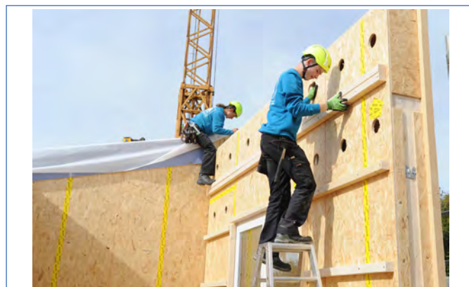
Azubi in Action Bildquelle: Jura Holzbau GmbH
